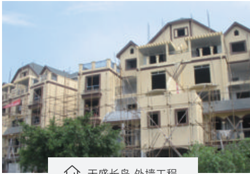
天盛长岛-外墙工程
