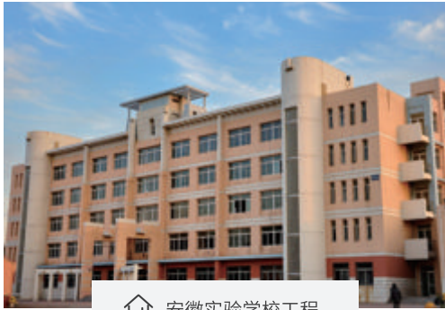
安徽实验学校工程
