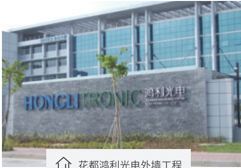
花都鸿利光电外墙工程
